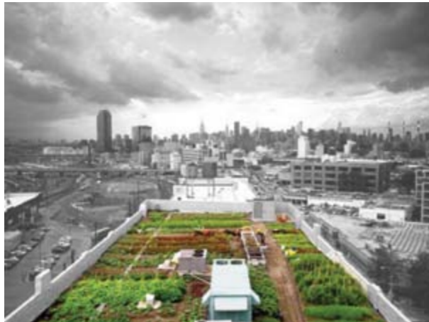
Slika : Dobar primer rekonstrukcije : zeleni krov koji apsorbuje padavine, povećava termalnu masu i smanjuje pregrevanje tokom leta
