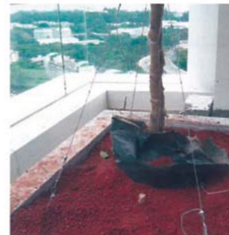
Slika 4. Učvršćivanje stabla metalnim sajlama
