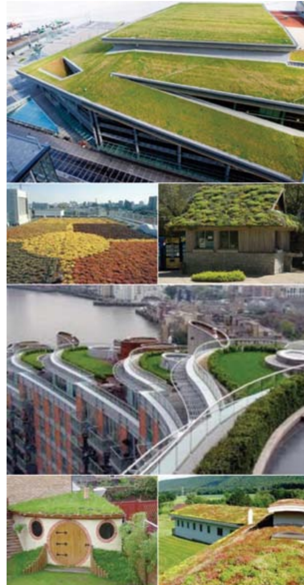
Slika 2: Ekstenzivni zeleni krovovi
